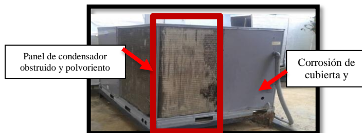
Figura 2. Condición física de los equipos de expansión directa Fuente: Elaboración Propia (2019)
