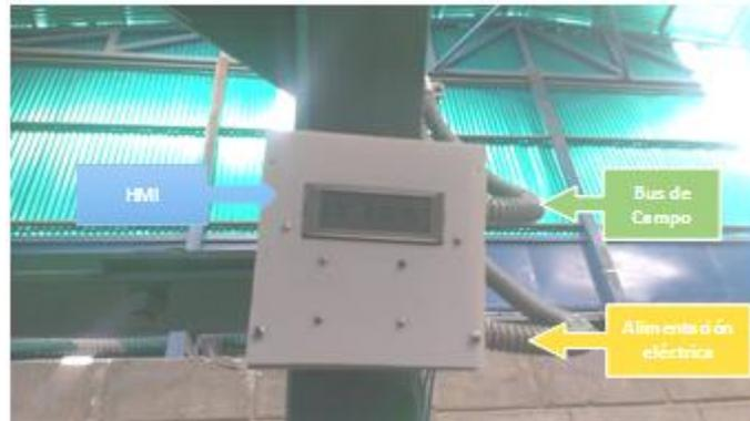
Figura 11. Unidad maestra de Recolección de Datos con HMI
