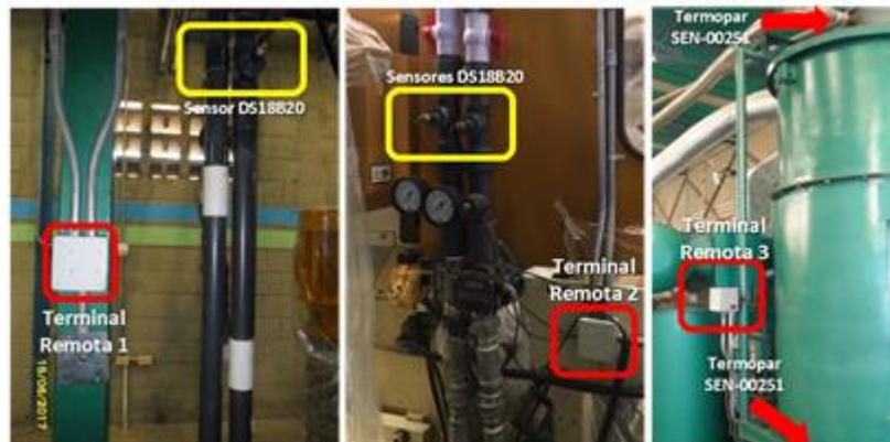
Figura 10. Ubicación de las terminales remotas con sus instrumentos
